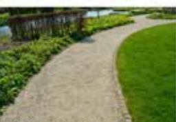
Padvast halfverharding laag van 12 cm op 5 cm zand op ca. 10 cm aanwezige schelpenpaden (Schelpenlaag was 20 cm, maar is ingeklonken)
